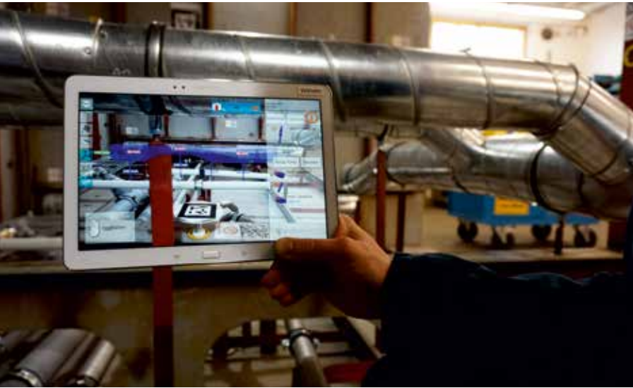
Bild 1: Einsatz der digitalen Arbeitsunterlage (AR-Modus).
